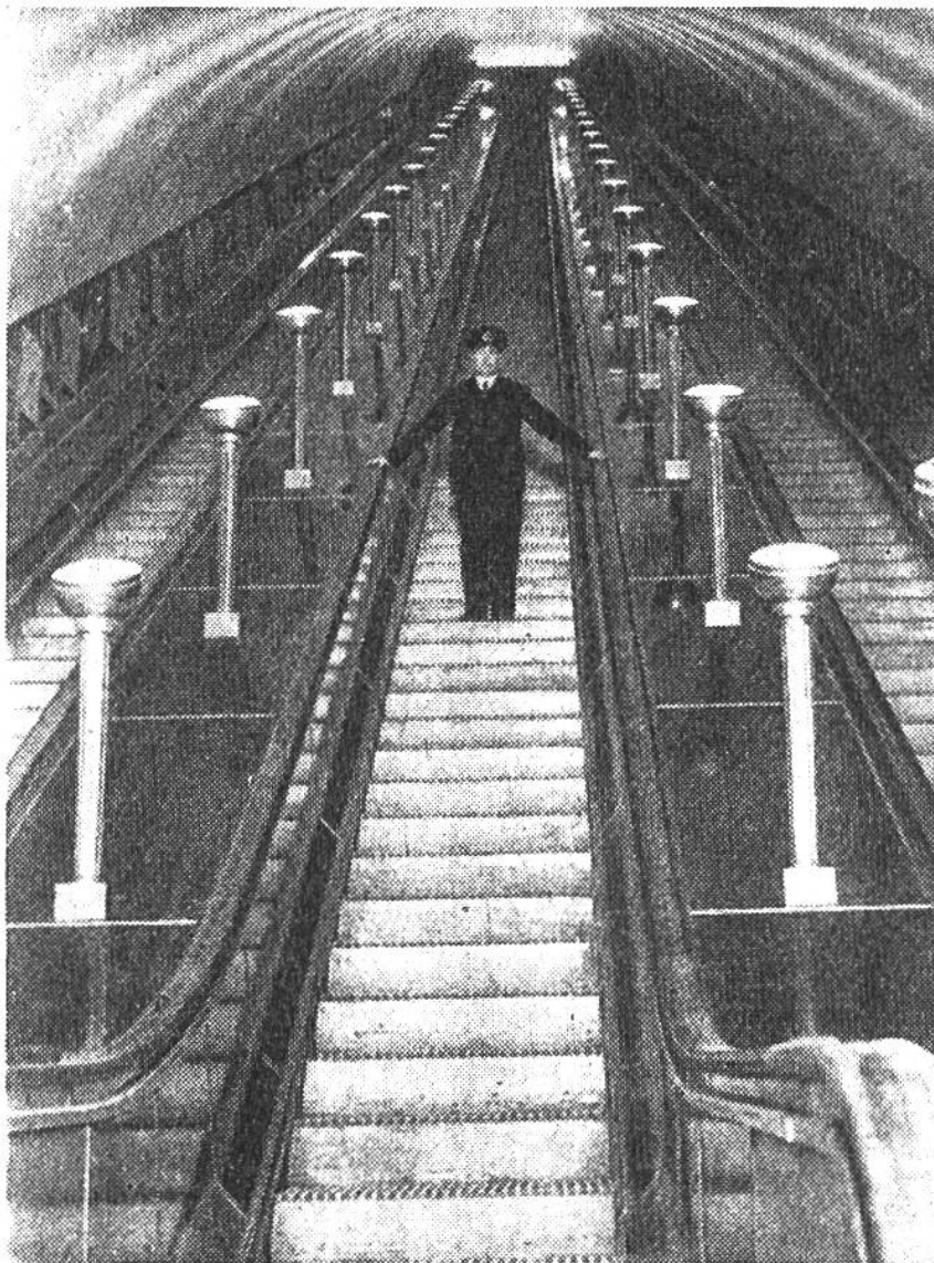
Die Rolltreppen der Station Leicester Square in London; sie führen zu den im Stadttinnern tief in der Erde befindlichen Untergrundbahnlinien. Jedes der Treppenbänder weist 304 Stufen auf und ist 53 m lang. Man glaubt, in einen hellerleuchteten Saal und nicht in einen abwärts führenden Tunnel zu treten.
