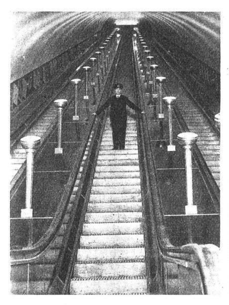
Die Rolltreppen der Station Leicester Square in London; sie führen zu den im Stadtinnern tief in der Erde befindlichen Untergrundbahnlinien. Jedes der Treppenbänder weist 304 Stufen auf und ist 53 m lang. Man glaubt, in einen hellerleuchteten Saal und nicht in einen abwärts füh-Tunnel zu renden treten.
