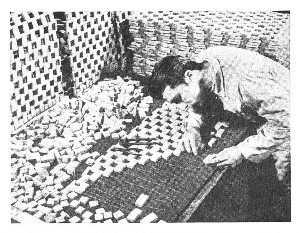
Herstellung von gleitsicheren und rasch trocken werdenden Korkmatten für Küche und Badezimmer.
