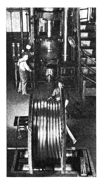
Bleikabelpresse, mit der eine geschlossene Hülle um das Kabel gebracht wird. Die Temperatur des Bleis beim Pressen ist ca. 180° C. Das Metall wird bei dieser Temperatur kittartig.
