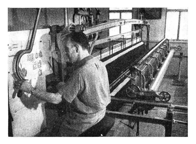
Der Handmaschinensticker arbeitet an der Handstickmaschine, die gewissermassen mit vielen Nadeln die Bewegungen einer Handstickerin macht. Mit der linken Hand führt er den Pantographen auf der technischen Stickerei-Zeichnung, wo jeder Stich eingezeichnet ist. Mit der rechten Hand treibt er den Wagen, an welchem die Nadeln befestigt sind, hin und her.
