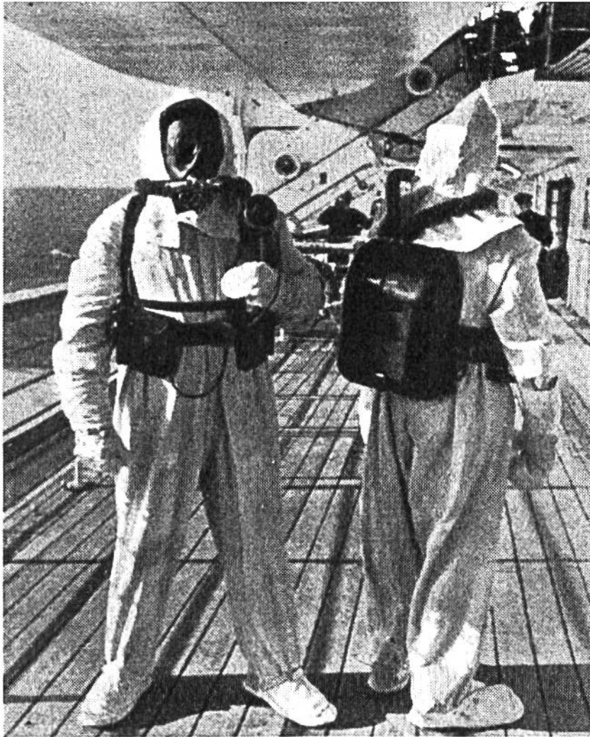
In Asbestanzüge gekleidete Feuerwehrleute auf einem grossen Passagierdampfer. Im Ernstfalle können sie, durch diese Kleidung geschützt, in unmittelbare Nähe des Brandherdes vordringen und so dem Feuer schneller Einhalt gebieten.
