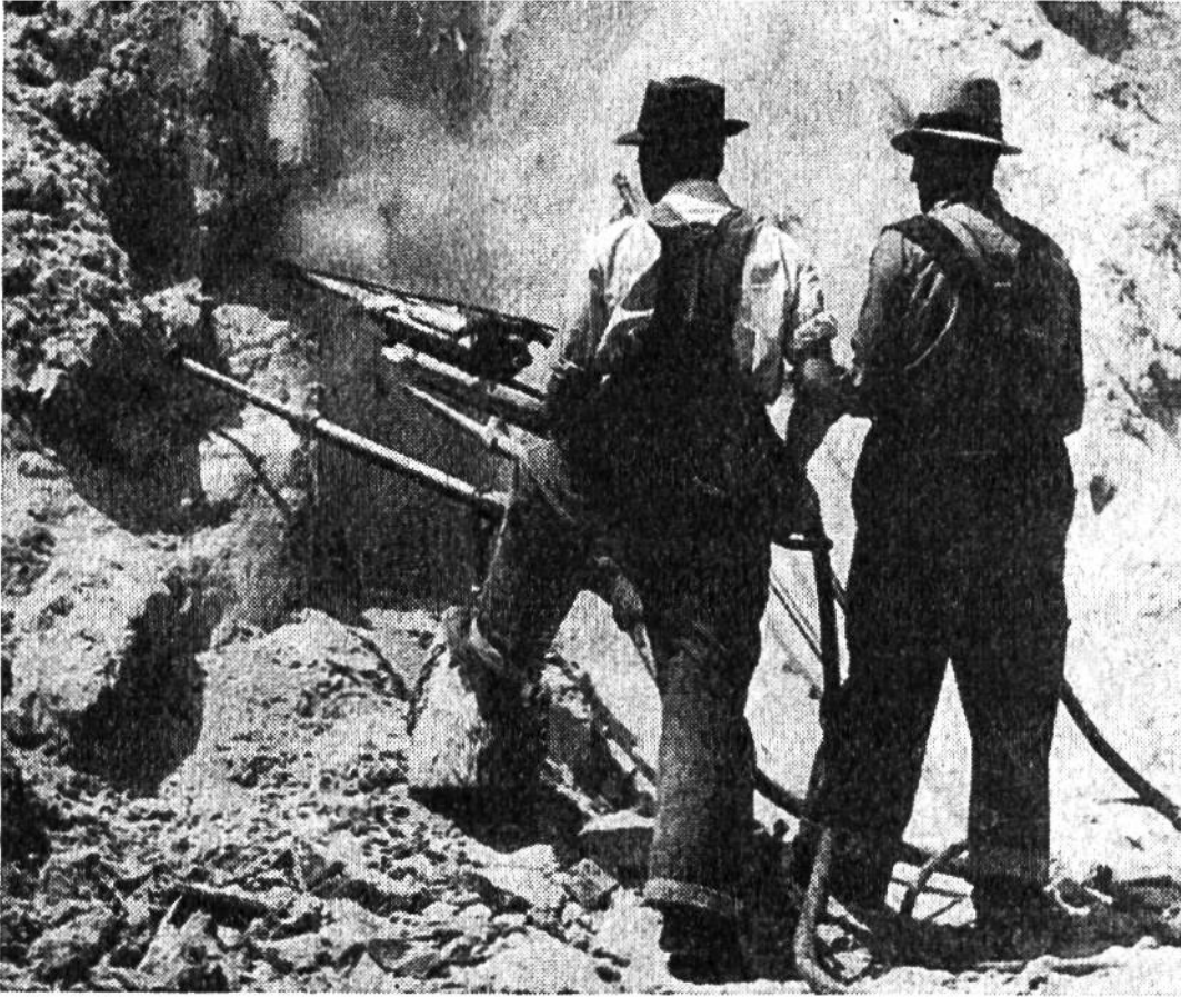
Mittels starker elektrischer Bohrmaschinen wird das asbesthaltige Gestein losgebrochen.
