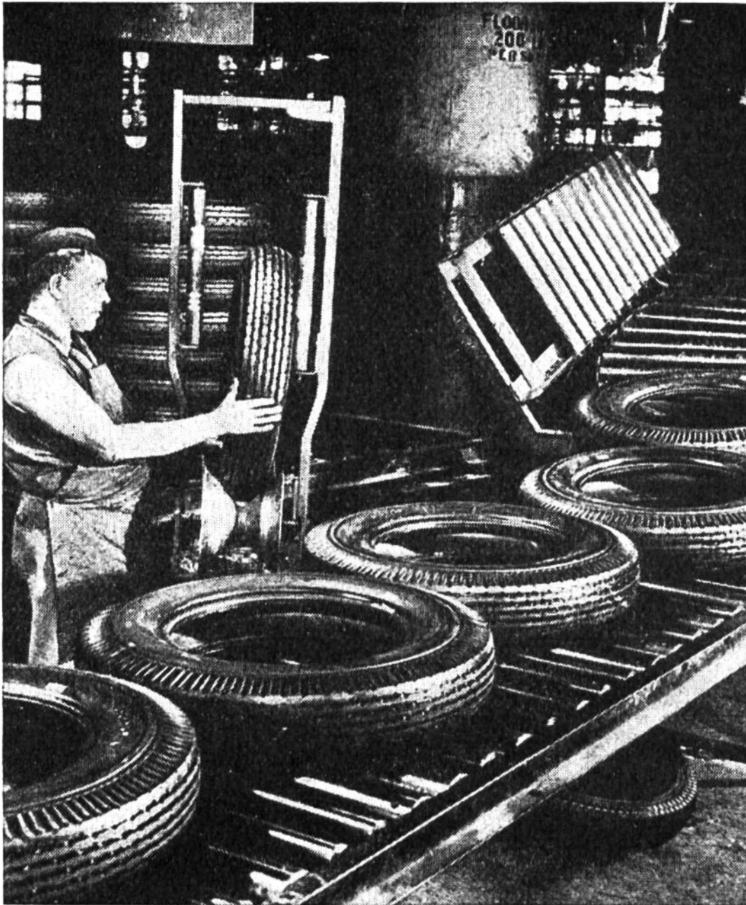
Nach einer letzten genauen Prüfung gelangen die versandfertigen Reifen auf einem Fließband in die Lagerräume.
