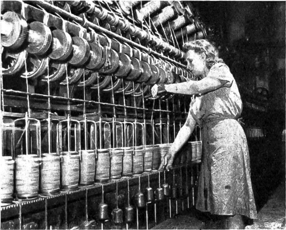
An dieser Spinnmaschine entsteht aus den losen Strähnen das als Rohmaterial für Seilerwaren dienende Garn.
