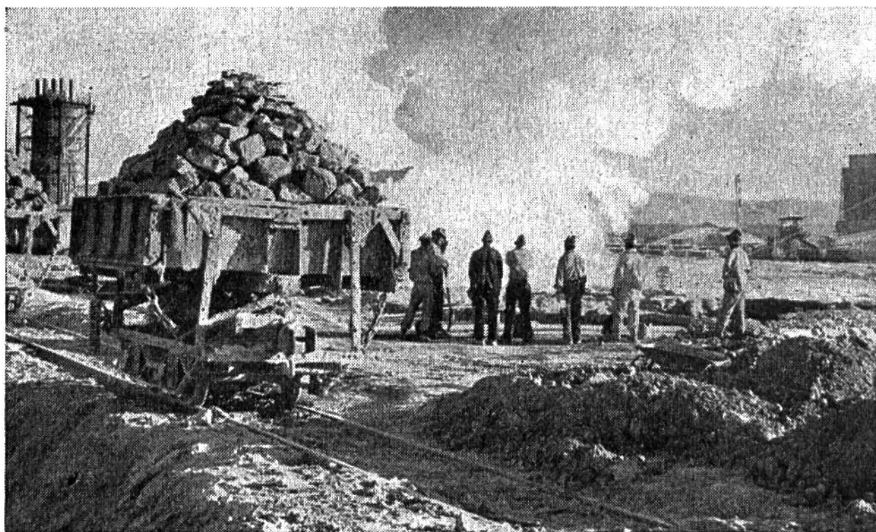
Erzeugung des für die Jodgewinnung wichtigen Natriumkarbonates durch Verbrennung von Kohle und Chilesalpeter.
