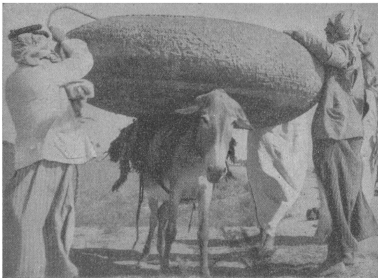
Esel tragen die schweren Boote über Land zur nächsten Flussüberquerung.
