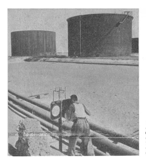
In der Nähe der riesigen Öltanks liest ein Angestellter den Ölstand der "Pipe Line" (Ölleitung) ab.
