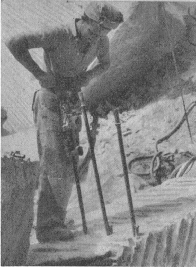
Mit Pressluftbohrern werden Löcher in den Stein getrieben. Bereits gebohrte Löcher werden mit langen Eisenstangen verstemmt.
