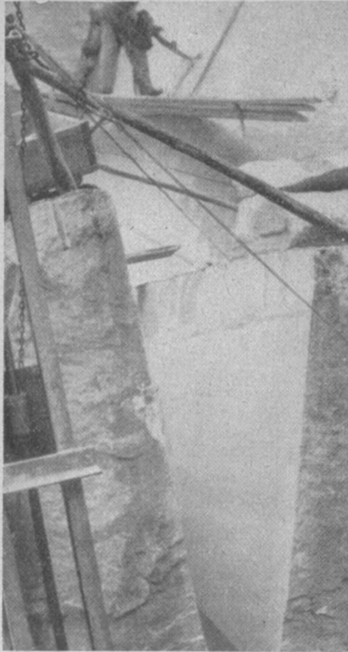
Ein Marmorblock von 50 t wird vom Berg losgetrennt.
