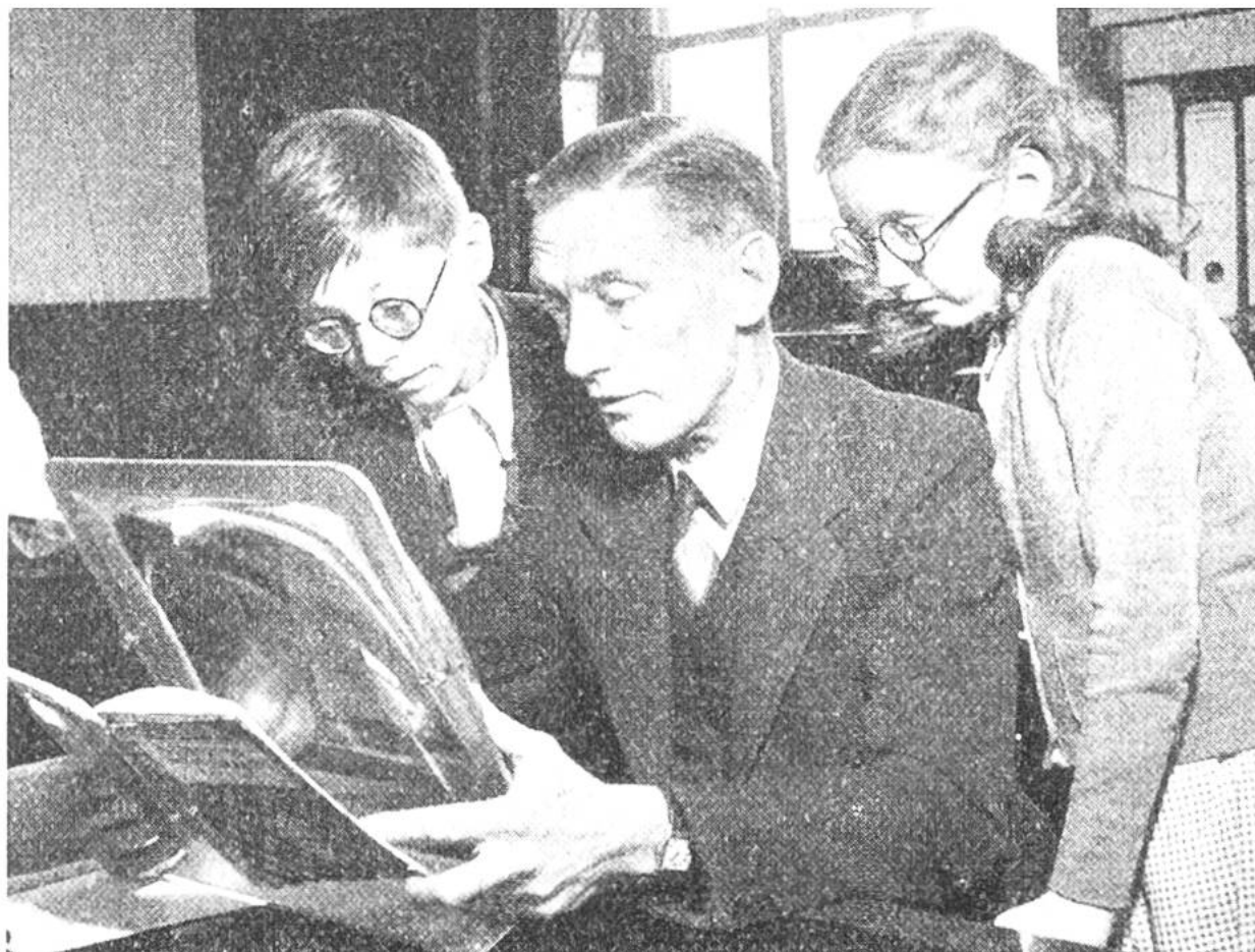
Leseversuch mit der Televisionslinse, die mit einer Flüssigkeit gefüllt ist. Die Kinder müssen dem Direktor sagen, ob sie damit lesen können.
