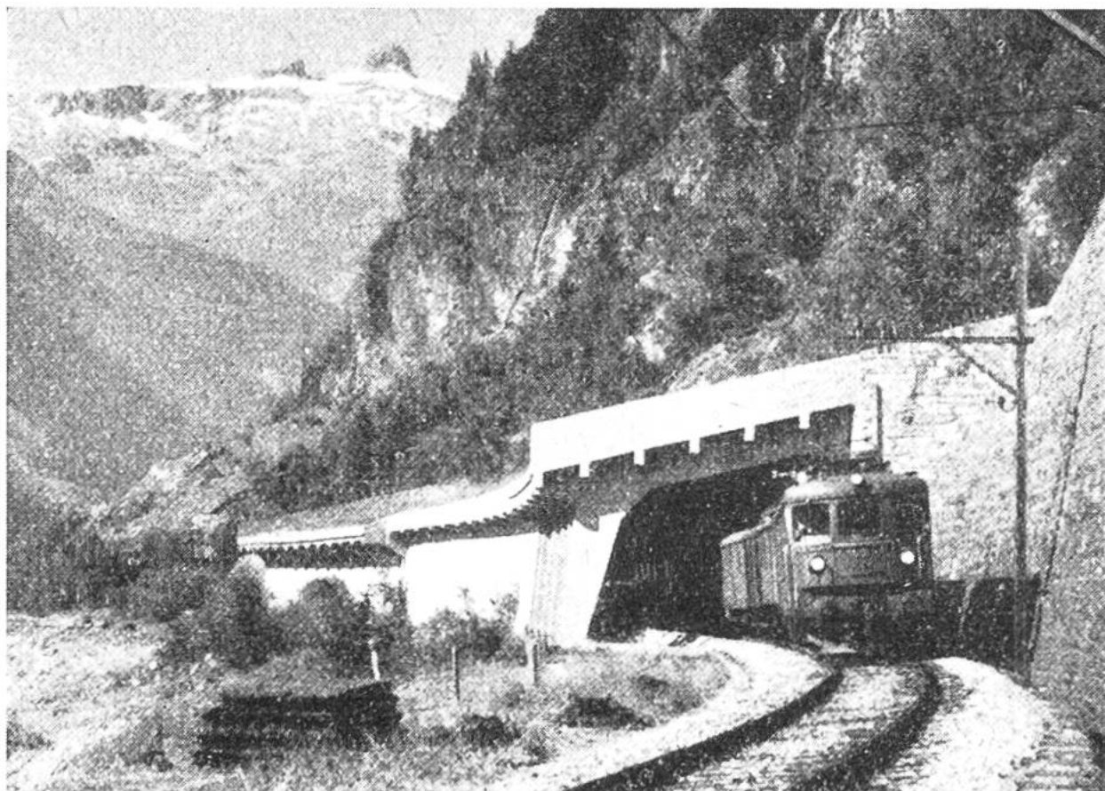
Ein Lötschbergbahnzug mit moderner 4000 PS-Lokomotive durchfährt eine Eisenbetongalerie. In der wilden Lonzaschlucht unterhalb Goppenstein schützen fünf Eisenbeton- und Eisengalerien von total 461 m Länge den Bahnkörper gegen Lawinen, Steinschlag, Felssturz und Wildwasser.
