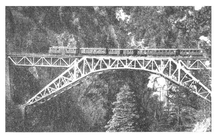
Eine der zahlreichen kühnen Brücken der Lötschbergbahn: Mit einem Bogen von 95 m Spannweite setzt sie in 75 m Höhe über das hier schluchtartig wilde, einsame Bietschtal am Südhang des Lötschbergs. Ihr Bau benötigte rund 1000 Tonnen Eisen.
