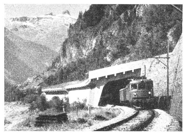
Ein Lötschbergbahnzug mit moderner 4000 PS-Lokomotive durchfährt eine Eisenbetongalerie. In der wilden Lonzaschlucht unterhalb Goppenstein schützen fünf Eisenbeton- und Eisengalerien von total 461 m Länge den Bahnkörper gegen Lawinen, Steinschlag, Felssturz und Wildwasser.
