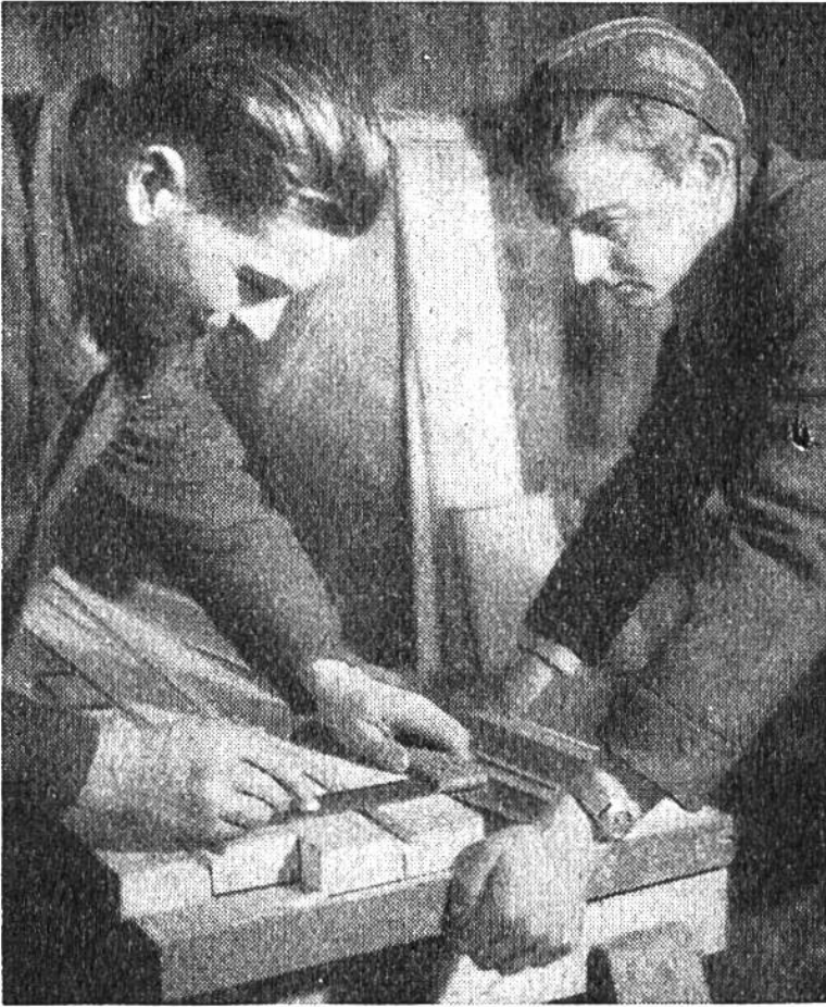
Der Kursleiter, links, ein fachkundiger Zimmermann, erklärte einem Kursteilnehmer das Anreissen bei einem Fensterrahmen.
