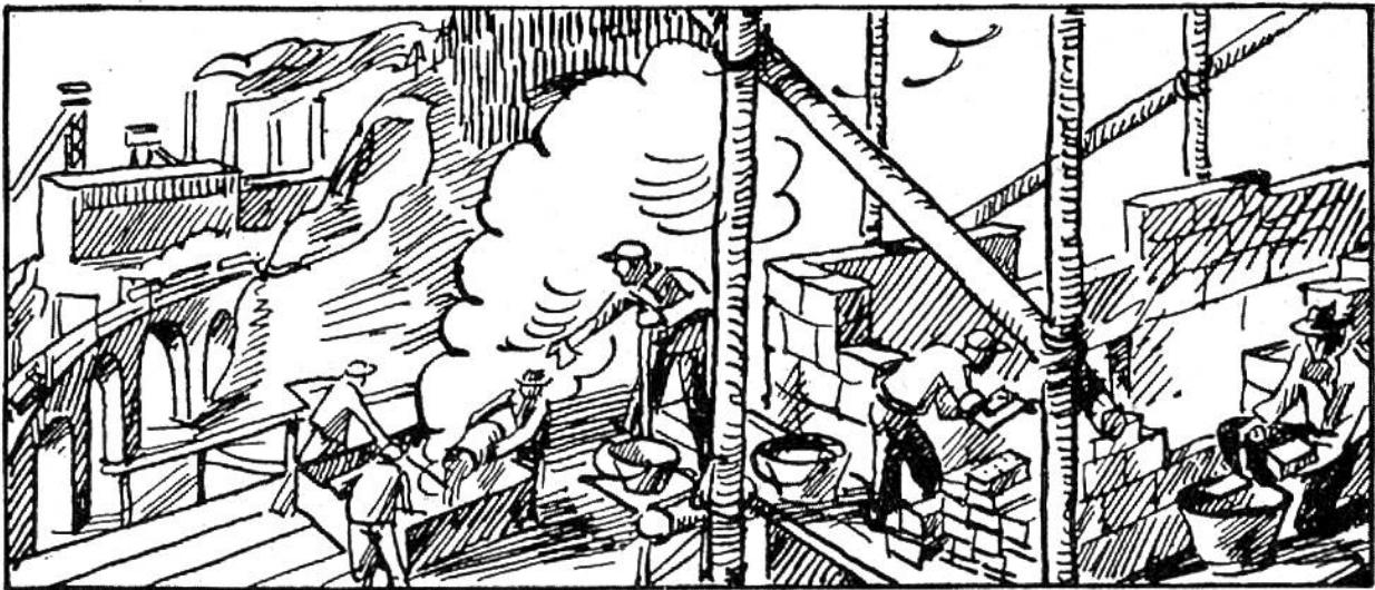
**Kalk** (gemeiner Kalkstein) findet in der Technik mannigfache Verwendung, doch muss er in den meisten Fällen gebrannt werden. Befeuchtet man gebrannten Kalk mit Wasser, so verbindet er sich mit diesem unter starker Erhitzung und zerfällt zu einem weissen Pulver, dem gelöschenen Kalk. Man unterscheidet fetten Kalk (unter 10% Tongehalt), mageren Kalk (über 10% Tongehalt) und hydraulischen Kalk (mit besonders grossem Tongehalt). Ein Gemenge von gelöschtem Kalk und Sand ergibt Mörtel.
