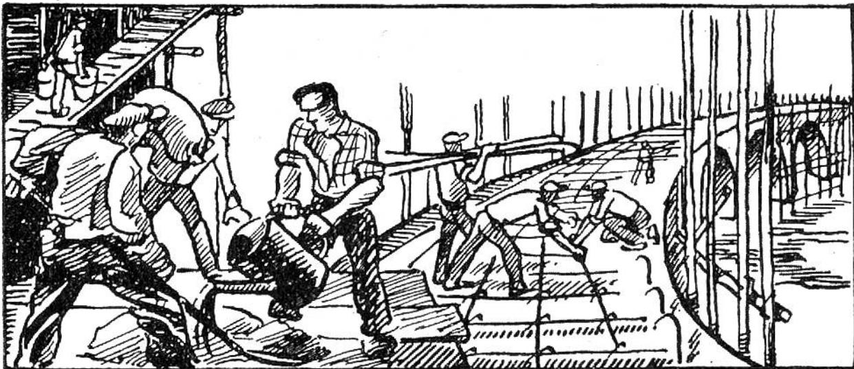
**Beton** heisst ein Gemenge von Zement, Kies und Sand, das mit Wasser feucht und formbar gemacht wird. Aus Beton werden Kanalröhren, Fundamente usw. gestampft. Wird der Beton durch Einlage von Eisenstäben verstärkt (armiert), so erhält man Eisenbeton, ohne den moderne Bauten wie Tunnels, Brücken, Talsperren, nicht möglich wären.
