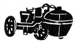
1769 fuhr der erste Dampfmotorwagen, ein Vorläufer der Lokomotiven und Automobile. Der Franzose Cugnot hatte ihn im Auftrag der franz. Regierung für den Transport schwerer Geschütze gebaut; es war ein schweres, dreiräderiges
