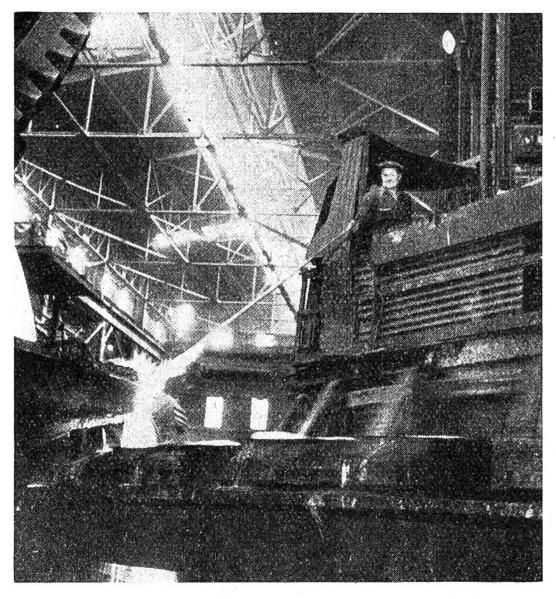
Eine der grossen Schmelzanlagen, in denen aus dem Erz wertvolle Metalle ausgeschieden werden.
