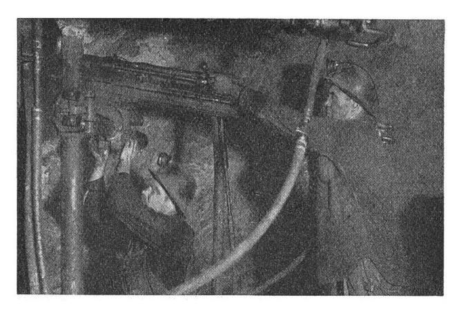
Mit Pressluftbohrern werden Sprenglöcher in einen Fels gebohrt, den eine Goldader durchläuft.
