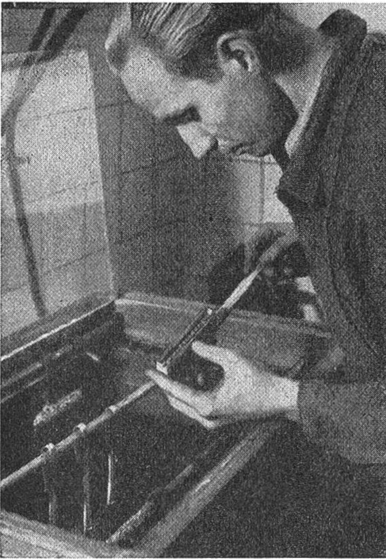
Abb. 2. Einhängen der gravierten Zeugoriginalbuchstaben in ein galvanisches Nickelbad zwecks Gewinnung der Nickelmatrizenhülsen.
