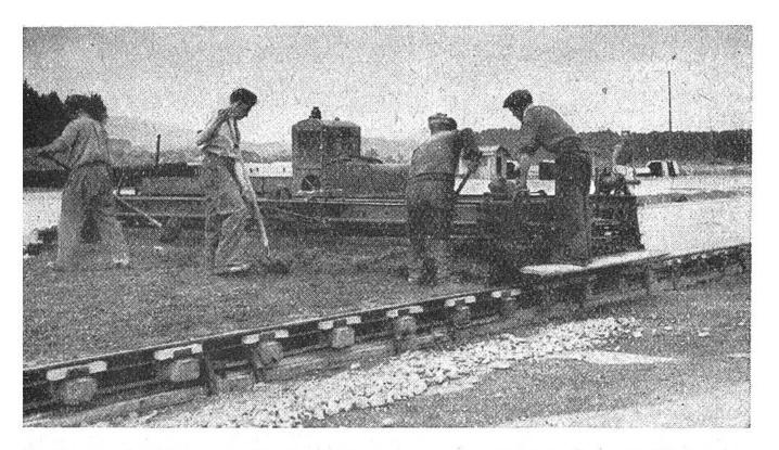
Bauarbeiten in Kloten. Das Betonmaterial ist über die Pistenfläche verteilt; nun kann der "Strassenfertiger" vorrücken, um es zu verdichten und festzustampfen. Die Maschine rückt in der Stunde um etwa 25 m vor, so dass täglich etwa 250 Laufmeter gelegt werden.
