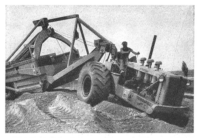
Bauarbeiten in Kloten. Der von einer Tournapull-Zugmaschine (mit zweiachsigem Motor) gezogene 10 Tonnen schwere "Scraper" ist ein Bodenhobler, der zu Planierungsarbeiten auf leichtem und mittelschwerem Untergrund eingesetzt wird. Er arbeitet mit einem Messer, das 30-50 cm in die Tiefe reicht; ist der Behälter gefüllt, so zieht sich das Messer automatisch ein.
