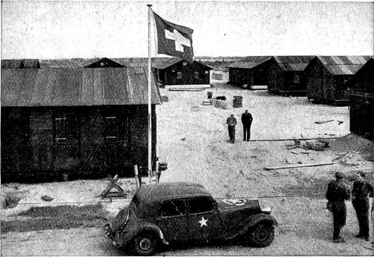
Über den Barackenlagern der Schweizer Spende wehte das weisse Kreuz im roten Feld.
