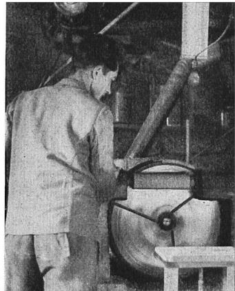
Dünne Sperrholzplatten werden in die für Böden und Dekkel benötigten Stücke zersägt.
