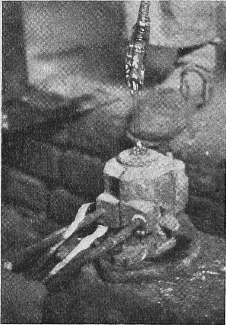
Das flüssige Glas wird vom erhöht stehenden Glasbläser in eine Form geblasen. Ein anderer Arbeiter hält die Form geschlossen.
