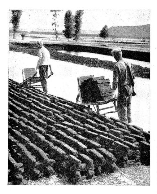
Der handgestochene, ungepresste Torf wird in der Nähe der Abbaustelle zur Trocknung ausgelegt.
