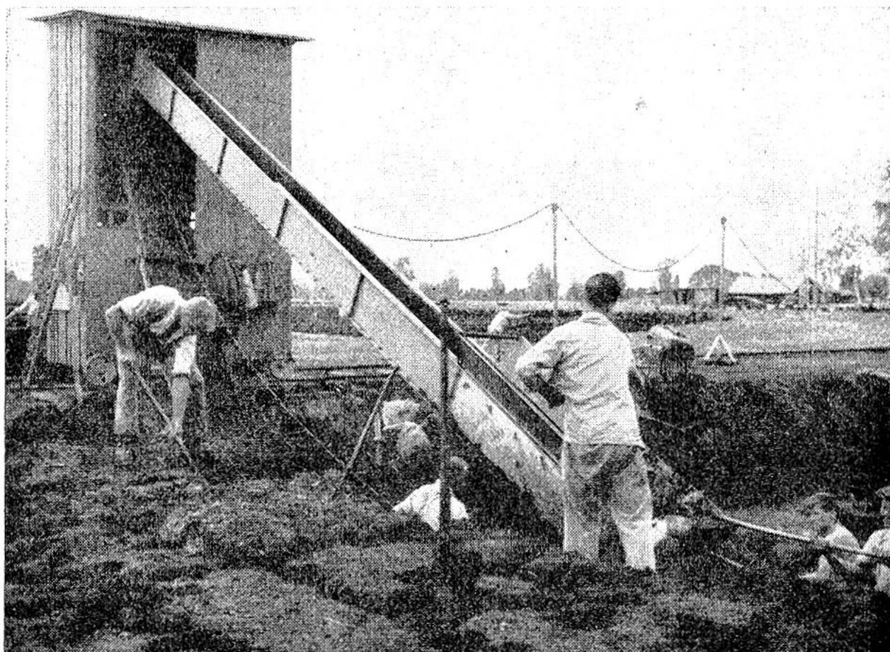
Eine fahrbare Torfmaschine in Betrieb. Die Geleise können leicht verlegt werden; das bewegliche Kabel leitet den Strom auf dem weitverzweigten Gelände nach dem jeweiligen Standort der Maschine.
