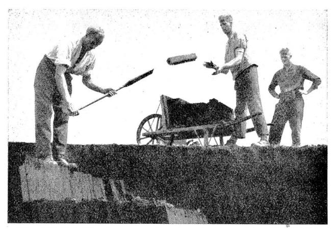
Abbau von Hand nach altgewohnter Art. Der Torf wird lagenweise mit einem besonders geformten Spaten abgestochen.
