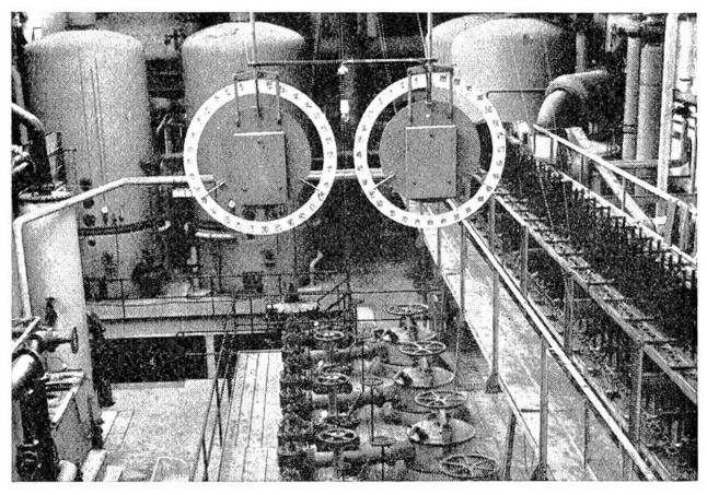
In den Entzuckerungsapparaten wird den Rübenschnitzeln mit warmem Wasser der Zuckersaft entzogen. Im Hintergrund einige Verdampfkessel, in denen der Zuckersaft verdickt wird. Die Einrichtung einer Zuckerfabrik ist sehr kostspielig.
