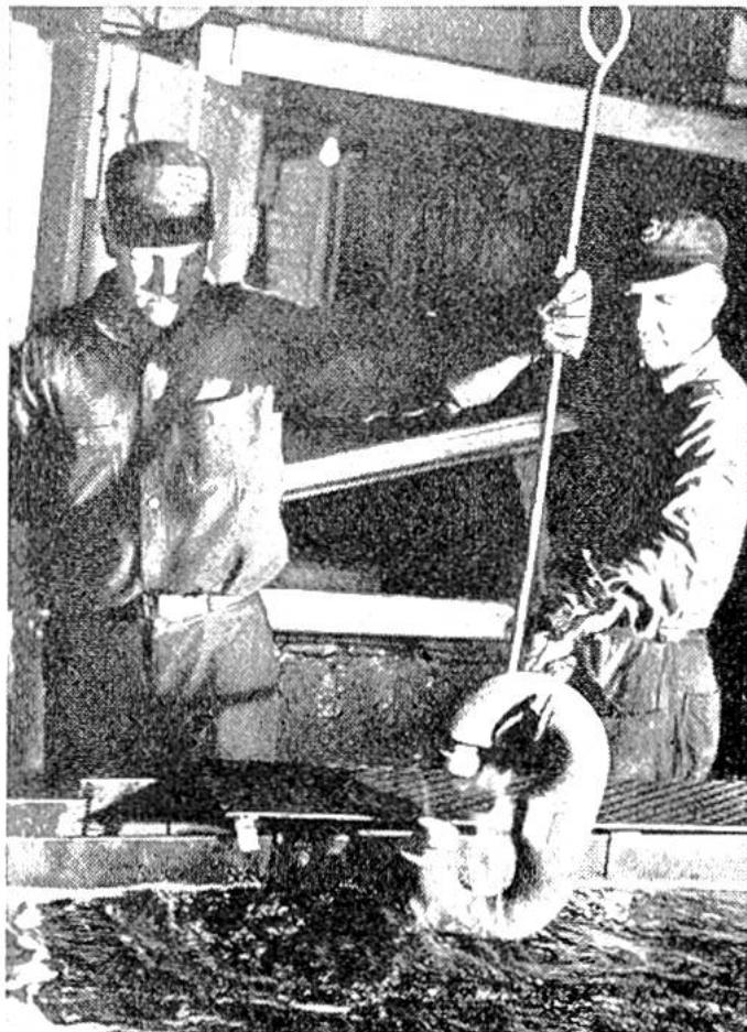
Links: So werden die riesigen, für grosse Schiffe bestimmten Ankerketten geschmiedet. Erst durch die bedeutenden Fortschritte in der Stahlbearbeitung ist es möglich geworden, solche Kettenglieder herzustellen. Rechts: Die einzelnen Glieder werden vor dem Zusammenfügen zu einer Kette im Ölbad gehärtet.
