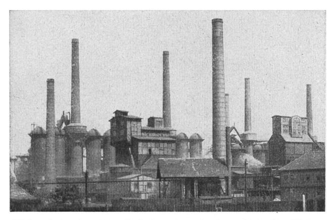
Blick auf eine der vielen Hochofenanlagen im Saargebiet; sie gehört zu den grossen Eisen- und Stahlwerken des Röchlingkonzerns. Hier wird das Eisen aus dem Erz geschmolzen, wobei die Schlacken entstehen.
