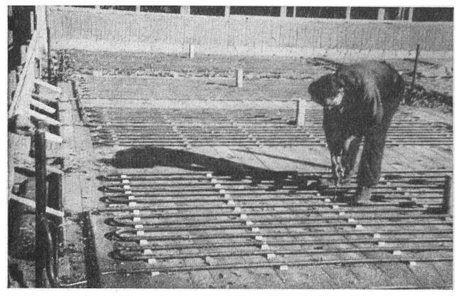
Montage einer Strahlungsheizung (System Crittall). Die Röhren, durch die später warmes Wasser fliesst, werden in der Decke verlegt. Darüber kommt eine Eisenbetonschicht mit Abdichtung gegen den Fussboden des folgenden Stockwerkes.
