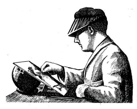
Der Modelleur entwirft und verfertigt das Originalmodell, das dann zum Prägen verkleinert wird.
