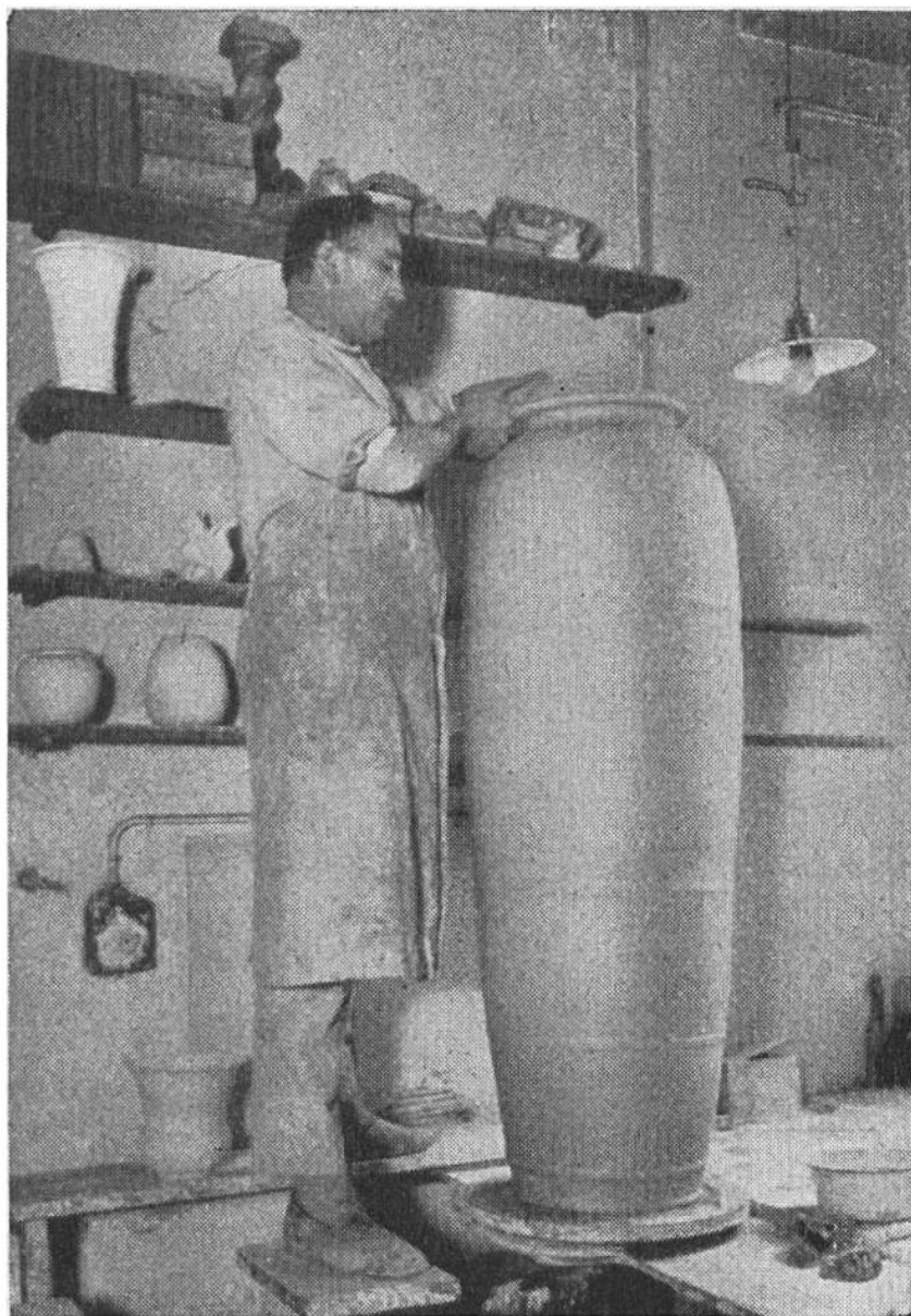
Eine 1 ½ m hohe Tonvase wird auf der Töpferscheibe frei- drehend hergestellt.
