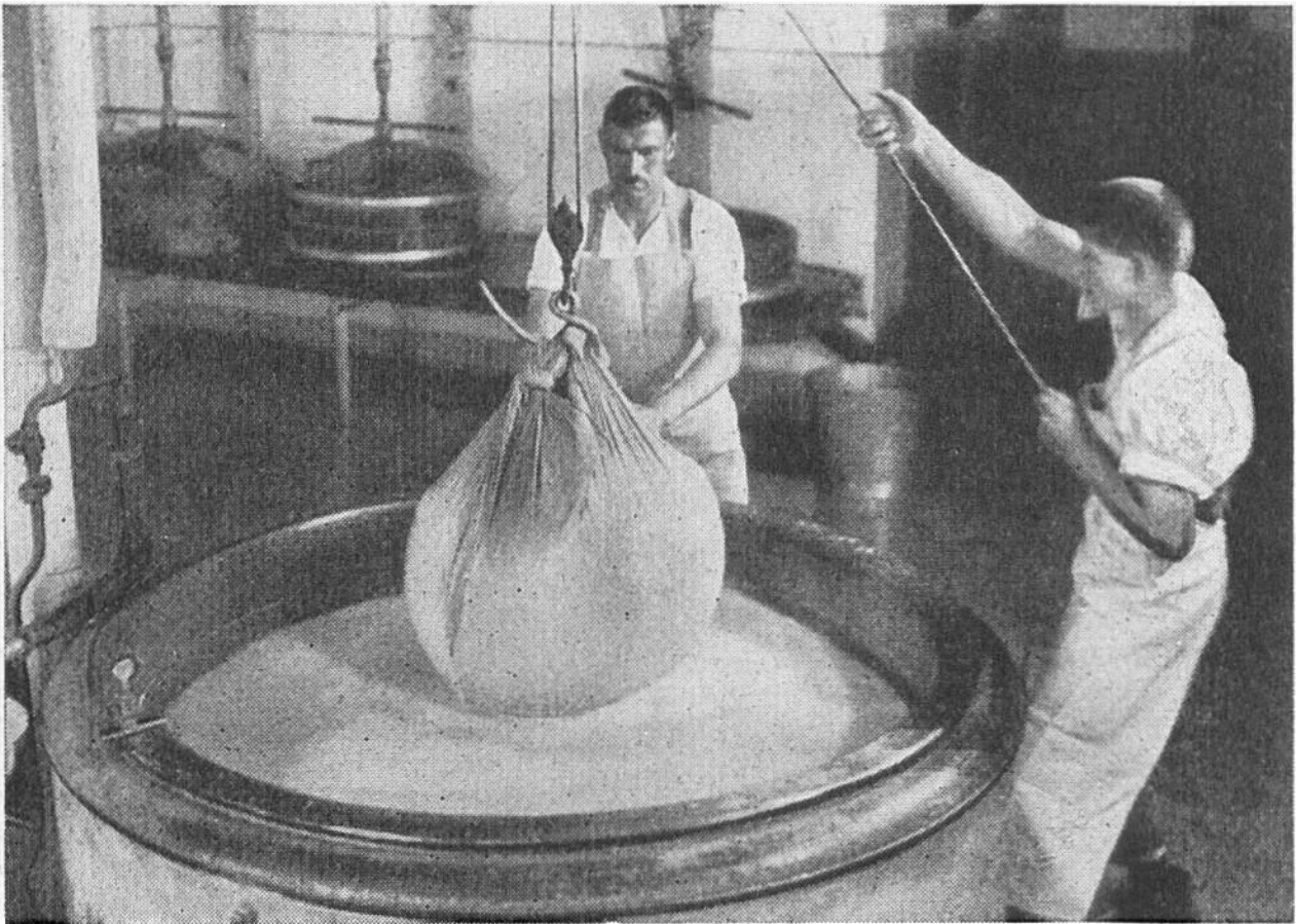
8. Hier ist die Käsemasse! Die Zipfel des Käsetuches sind zusammengeknüpft und an einen Flaschenzug gehängt worden.
