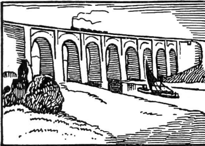
18. Neun-Bogen-Viadukt an der Bahnstrecke Liverpool-Manchester.
