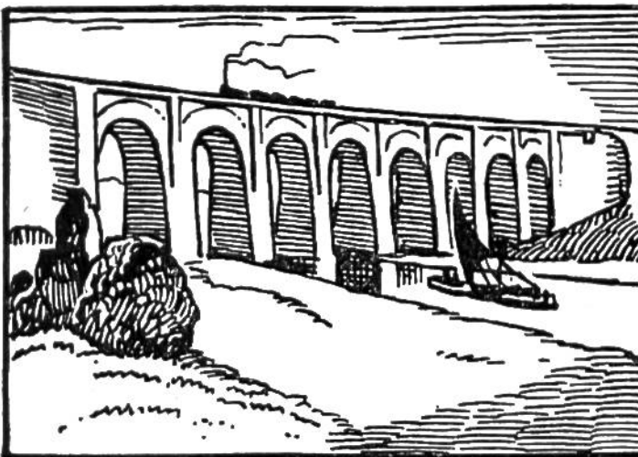
18. Neun-Bogen-Viadukt an der Bahnstrecke Liverpool-Manchester.
