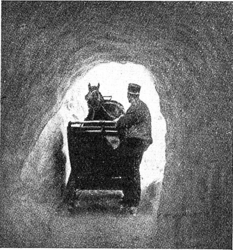
Schneetunnel zur Aufrechterhaltung des Verkehrs. Vor Eröffnung der Albulabahn musste dieser Tunnel jeden Winter erstellt werden.
