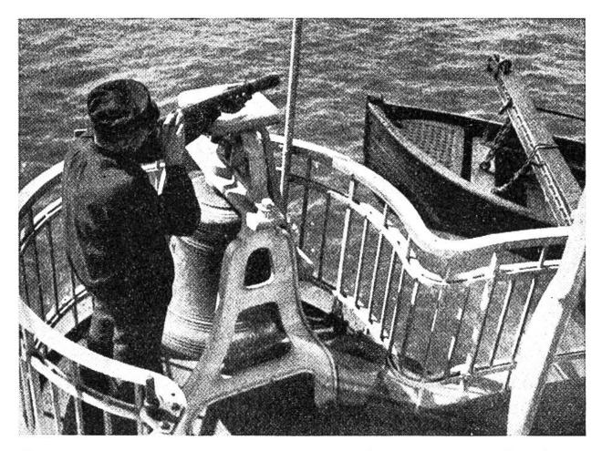
Der Wächter beim Ausguck, auf dem obersten Rundgang des Turmes; vor ihm die Nebelglocke, die bei nebligem Wetter und in der Nacht angeschlagen wird. An einem eisernen Arm des Leuchtturms hängt das Rettungsboot; es ist in ständiger Bereitschaft, damit Schiffbrüchigen sofort zu Hilfe geeilt werden kann.
