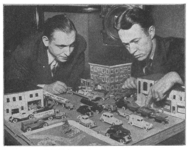
Im Institut zur Prüfung von Verkehrsunfällen. Mit Hilfe von Modellen werden schwierige Verkehrsprobleme zu lösen versucht.
