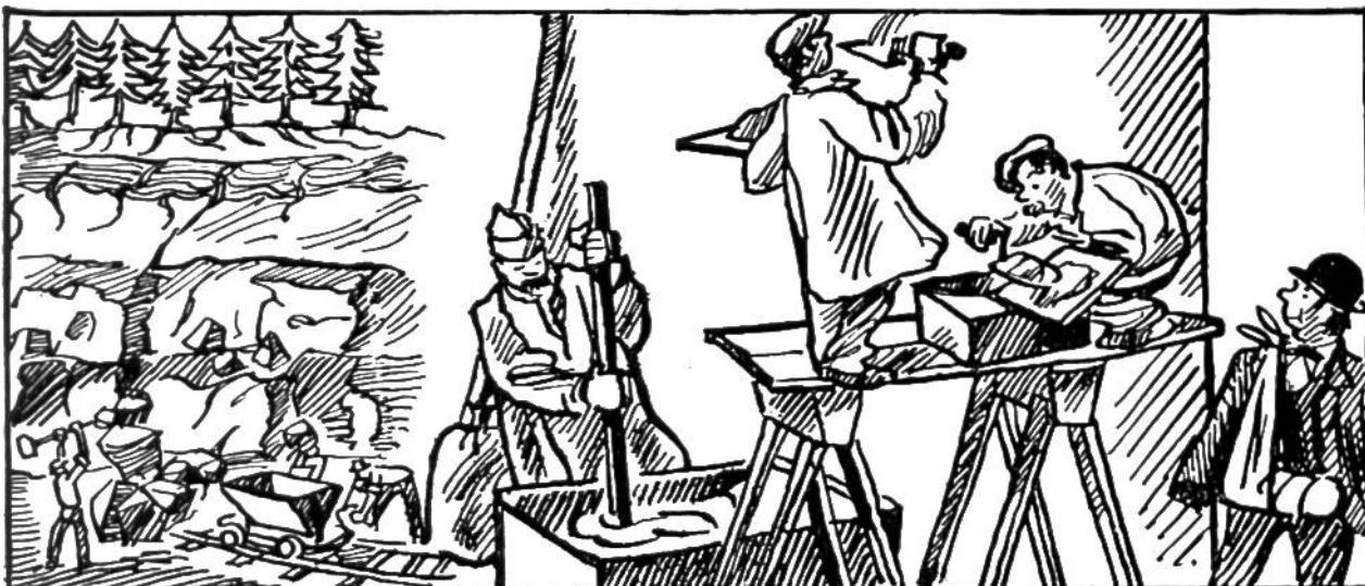
wetterbeständig. Er wird viel zu Statuen, Abgüssen und im Baugewerbe verwendet. Gar mancher verdankt die gute Heilung eines Bruches dem Gipsverband. Gips, der bei  $450^{\circ}$  gebrannt wird, erhärtet erst nach Wochen, wird aber äusserst fest und witterbeständig. Dieser Gipskalk ist ein schon im Altertum bekannter Mörtel.
