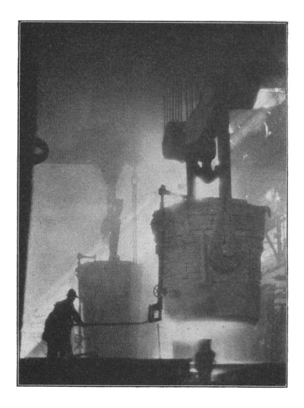
In der Giesshalle. Dieses schöne Bild ist in einem Stahlwerk aufgenommen worden. Die beiden gewaltigen Gefässe rechts neben den Männern sind sogenannte Pfannen, welche mit eben aus dem Schmelzofen kommendem flüssigen Stahl angefüllt werden. Krane und Flaschenzüge lassen diese Riesengewichte durch die weite Fabrikhalle schweben. Aus der Pfanne kommt der flüssige Stahl in die verschiedenartigsten Formen zum Erkalten.
