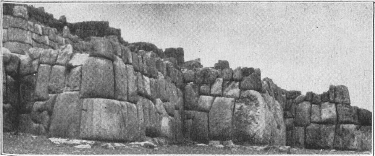
Die Mauern wurden oft ohne Mörtel aus riesigen Steinquadern aufgeführt, die zuweilen über 20 Tonnen schwer sind. Die einzelnen Steinkanten sind so geschickt geschliffen und derart genau zusammengefügt, dass noch heute keine Messerklinge zwischen den Fugen Platz hat.
