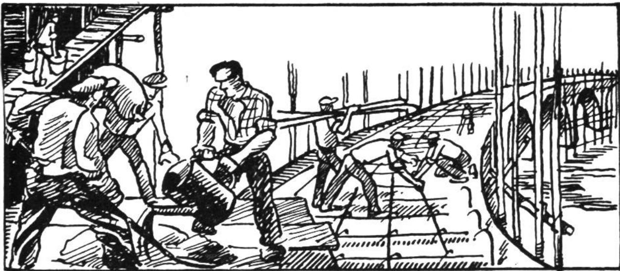
**Beton** heisst ein Gemenge von Zement, Kies und Sand, das mit Wasser feucht und formbar gemacht wird. Aus Beton werden Kanalröhren, Fundamente usw. gestampft. Wird der Beton durch Einlage von Eisenstäben verstärkt (armiert), so erhält man **Eisenbeton**, ohne den moderne Bauten, Tunnels, Brücken, Talsperren, nicht möglich wären.
