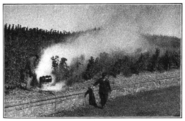
Frostbekämpfung im Weinberg durch Erzeugung von chemischen Nebeln. Die Nebelschwaden bedecken das Gelände und verhindern zu starke nächtliche Abkühlung.
