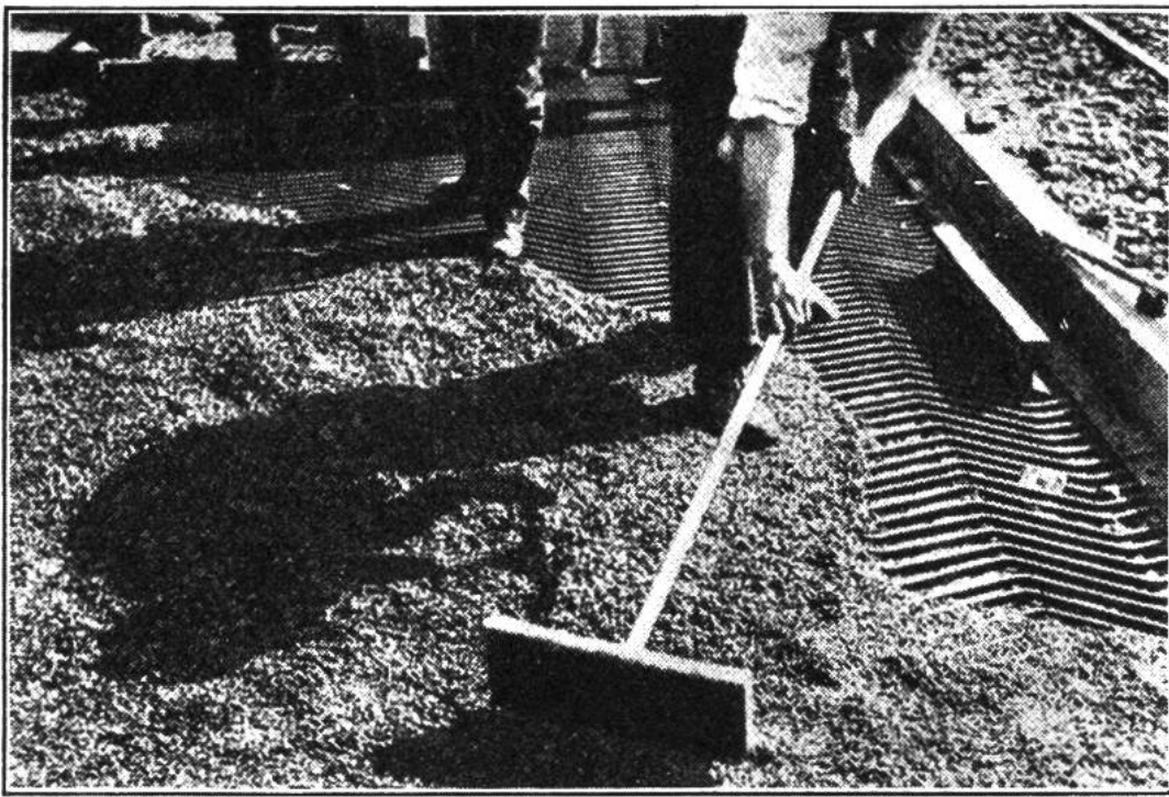
Teergetränkter Kies wird über das Stahlgerippe ausgebreitet und füllt die Zwischenräume.
