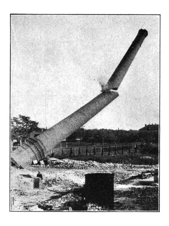
In vollem Sturz. Eine Sekunde noch — dann wird die gewaltige Masse auf den Erdboden schmettern und in tausend Stücke zerfahren. Auffallend ist der Bruch des Kamines in der Luft; er erfolgt aber immer beim Fällen derartig gebauter Schornsteine und fast regelmässig unterhalb des obern Drittels. Der Bruch entsteht durch den Luftwiderstand, der oben am Kamin wegen des weiteren Fallweges und der raschern Fallbewegung bedeutend grösser ist.
