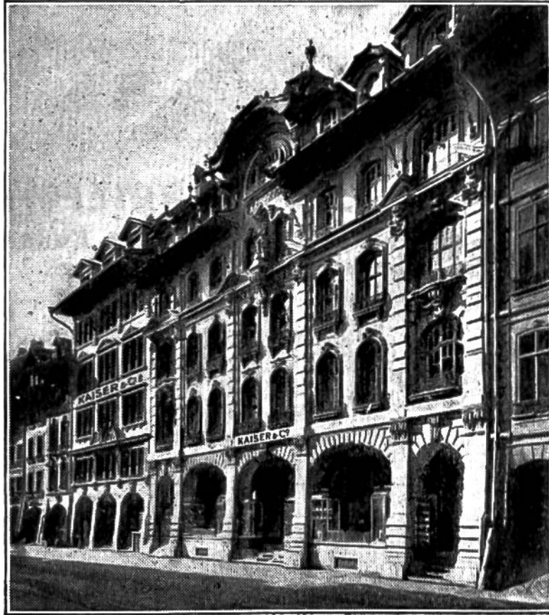
Teilansicht d. Geschäftshäuser Kaiser & Co. A. G. Marktgasse 37—43 durchgehend Amthausgasse
