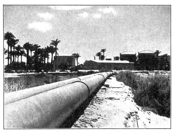
Über bebautes Land und über Steppengebiet, durch Wüsten und durch Oasen, Höhenzüge überwindend und Flüsse kreuzend zieht sich diese gewaltige Rohrleitung von Kerkuk im nördlichen Irak nach Haifa am Mittelmeer. Es ist eine kostbare Flüssigkeit, die durch diese beiden Rohre fliesst: Es ist Erdöl!
