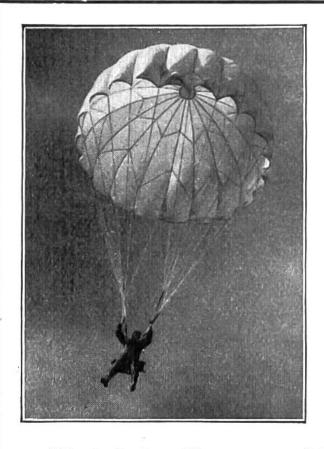
Hier sieht man deutlich, wie der Springer im Traggurt hängt, der durch die Fangleinen mit der Fallschirmhülle verbunden ist. Durch Ziehen der Leinen hat der Fallschirmabspringer eine beschränkte Lenkmöglichkeit.
