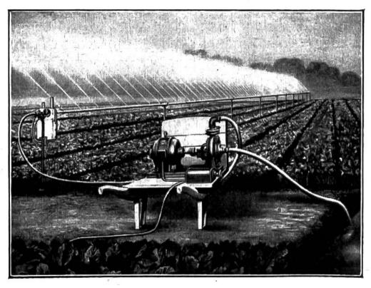
Weite Gemüse- und Blumenfelder können mittelst der fahrbaren Beregnungsanlage in kurzer Zeit bewässert werden. (Links auf dem Schubkarren ist der Motor, rechts die Saug- u. Druckpumpe.)
