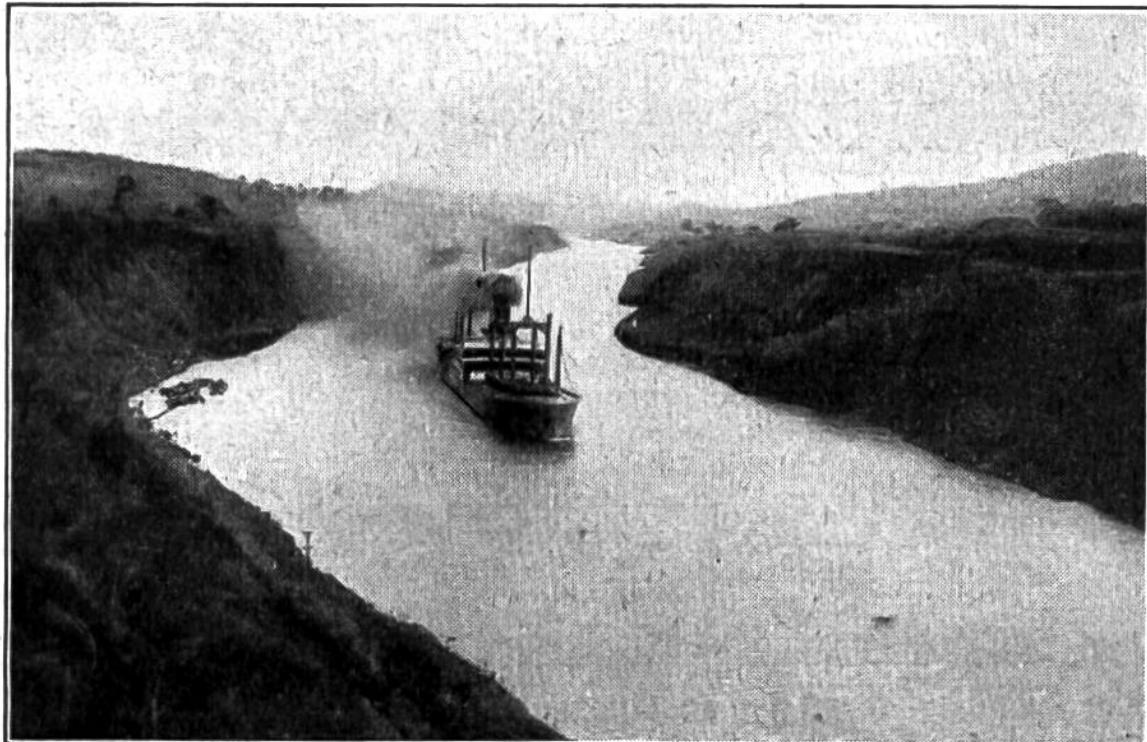
Beim Bau des Panama-Kanals machte eine hügelige Gegend mit brüchigem Gestein den Ingenieuren viele Schwierigkeiten. Da diese Strecke tief eingeschnitten werden musste, brachen öfters die Seitenränder los und verschütteten die Wasserstrasse.
