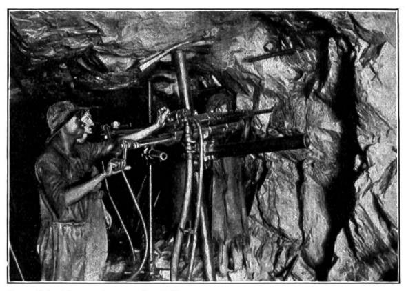
Im Stollen eines Goldbergwerkes. Mit Hilfe moderner Druckluftbohrer werden von Eingeborenen Südafrikas Sprenglöcher gebohrt. Der Stollen wird soweit vorgetrieben als es nötig ist, um zu den goldführenden Schichten zu gelangen.
