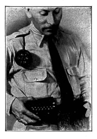
Batterie werden am Leibgurt des Polizisten befestigt, der Lautsprecher an seiner Schulter. Als Antenne dient der Körper des Trägers. Gerät, das nicht schwerer eine Dienstpistole als soll. ist auf sein den Polizeisender abgestimmt, so dass einem diensttuenden Mann jederzeit wichtige Nachübermittelt richten werden können.
