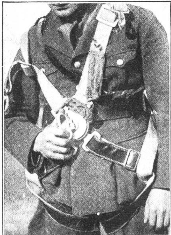
Bild oben: Im Augenblick höchster Gefahr. Der Pilot hat soeben den Erdboden erreicht; der gewaltig aufgeblähte Fallschirm würde ihn mit jedem Windstoss mitreissen, wenn er sich nicht sofort frei machen könnte dank dem neuen Zentralverschluss-Gurt. Bild unten: Mit einem einzigen Handgriff öffnet der Pilot den Verschluss, und im Bruchteil einer Sekunde ist er vom Fallschirm befreit.
